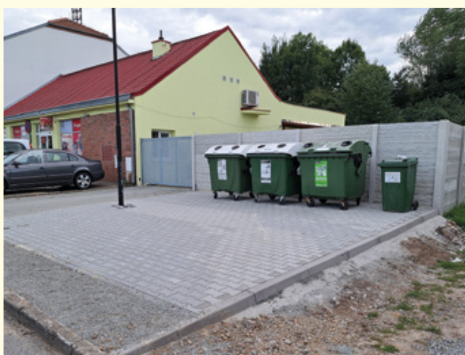
Budujeme pro Vás nové hnízdo na třídění odpadů, kde budou nově umístěny kontejnery na sklo a oleje.
